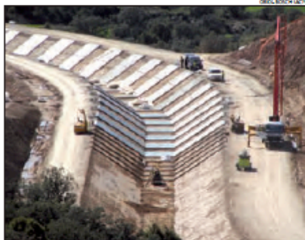
Imatge d'arxiu de les obres del canal a l'Urgell
